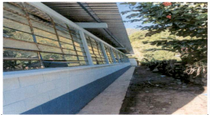
Foto 4: Pintura en muros exteriores e interiores
