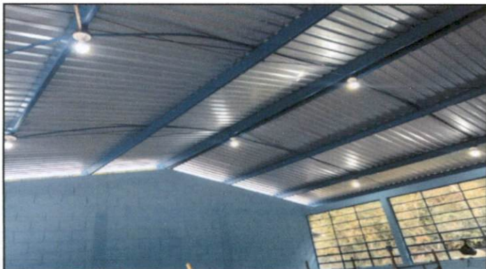
Foto 3: Mantenimiento a estructura de soporte de metal
